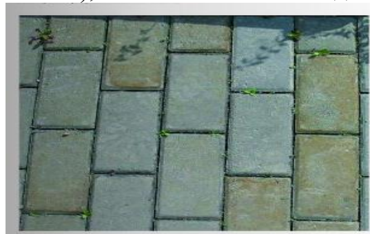
Рис. Желто-коричневые пятна, проявившиеся после укладки
